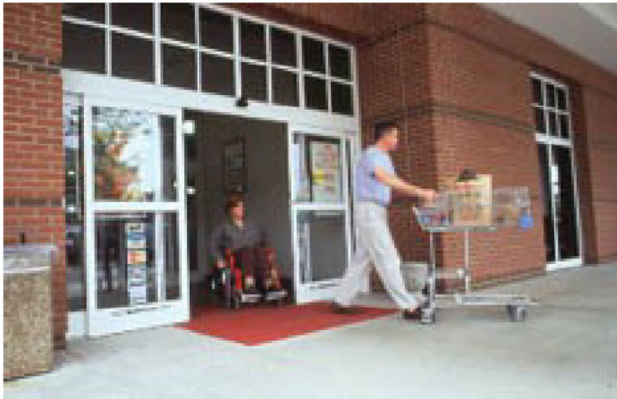
Figura 1 – Porta de abertura automática
